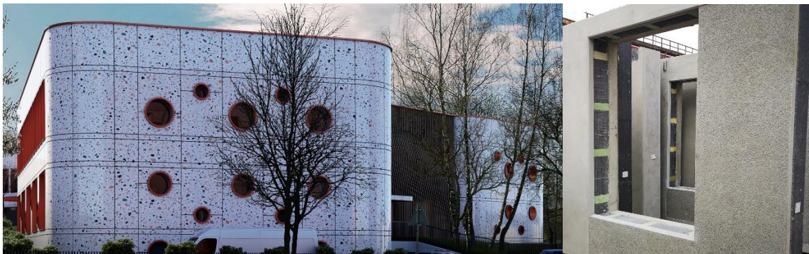
Trisluoksnių apšiltintų G/b surekamų sienų fasadas su spalvotais akmenukais apdailiniame betono sluoksnyje.
